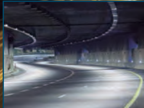
4.6.3.4. Ampliación túnel UASD (retorno sur-norte)
