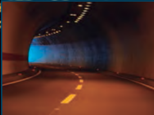
4.6.3.1. Túnel avenida Winston Churchill
