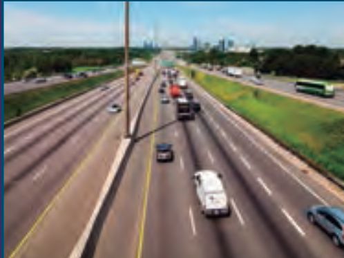
4.6.1.1. Ampliación de la avenida República de Colombia
