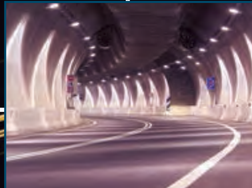
4.6.3.2. Túnel avenida Abraham Lincoln
