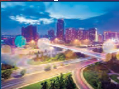
4.6.1.2. Elevado en la intersección de las avenidas Jacobo Majluta y República de Colombia
