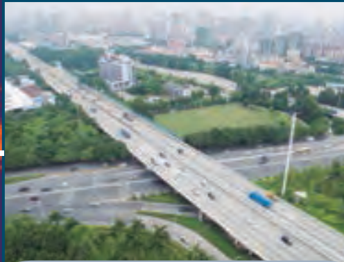
4.6.1.4. Paso a desnivel avenida Los Próceres - avenida República de Colombia
