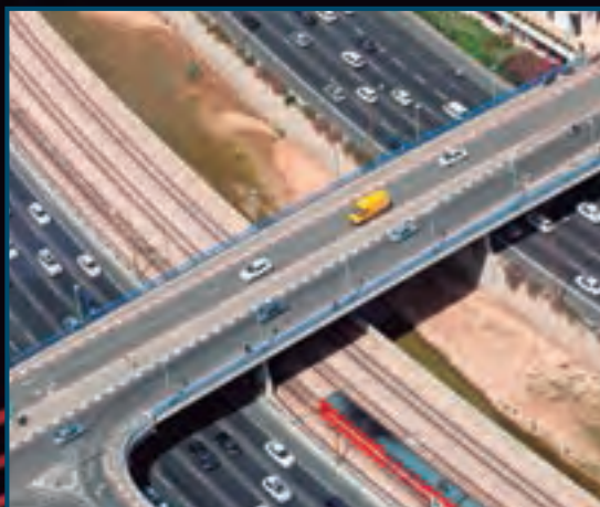
4.6.4.2. Paso a desnivel en la intersección de las avenidas 27 de Febrero e Isabel Aguiar
