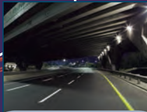
4.6.1.3. Paso a desnivel calle Sol Poniente - avenida República de Colombia
