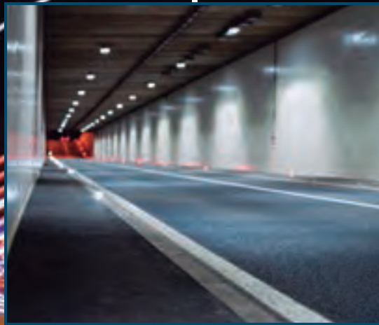
4.6.4.1. Túnel en la intersección de las avenidas 27 de Febrero y Gregorio Luperón
